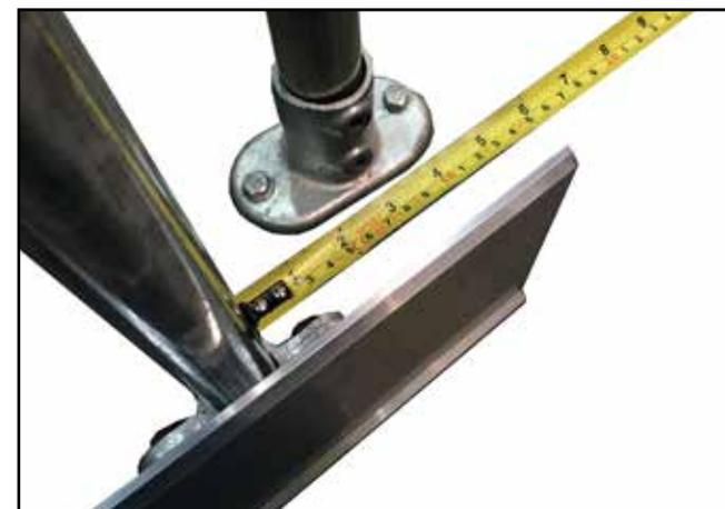
**11.** Vérifiez que la plinthe est bien centrée sur le cadre et serrez les écrous au couple de 15 Nm afin de vous assurer qu'elle est bien fixée.
