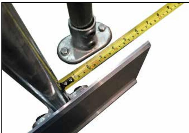
**9.** Vérifiez que la plinthe est bien centrée sur le cadre et serrez les écrous au couple de 15 Nm afin de vous assurer qu'elle est bien fixée.
