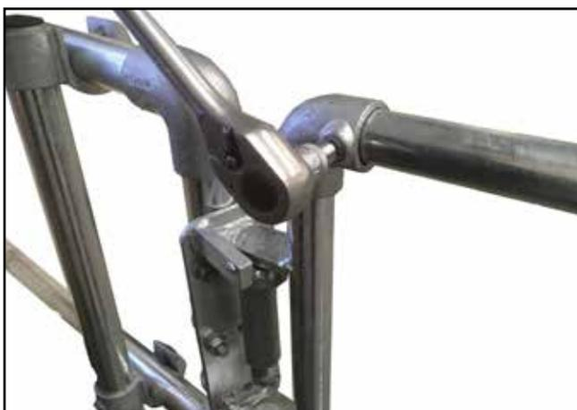
**J.** Repositionnez soigneusement les tubes supérieur et inférieur du portillon dans les raccords. Vérifiez la planéité du portillon à l'aide d'un niveau à bulle. Serrez les vis sans tête des raccords à l'aide d'une clé hexagonale. À l'aide de la clé dynamométrique, veillez à ce que les raccords soient serrés au couple de 39 Nm. **Répétez les étapes G-J pour le portillon de droite.**
