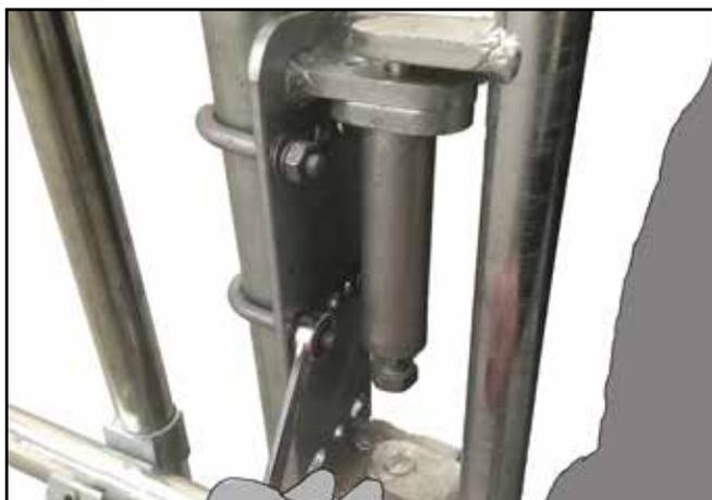
**C.** Faites passer l'étrier fileté autour du montant / structure d'appui, puis à travers les trous du **milieu** de la plaque de fixation. Assemblez l'étrier fileté à la plaque de fixation à l'aide d'une rondelle élastique, d'une rondelle plate et d'un écrou.
