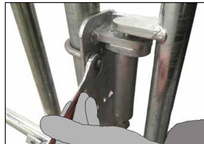
**B.** À l'aide d'une rondelle plate M8 ou M10 et d'un écrou, assemblez l'étrier fileté au montant / structure d'appui puis serrez.
