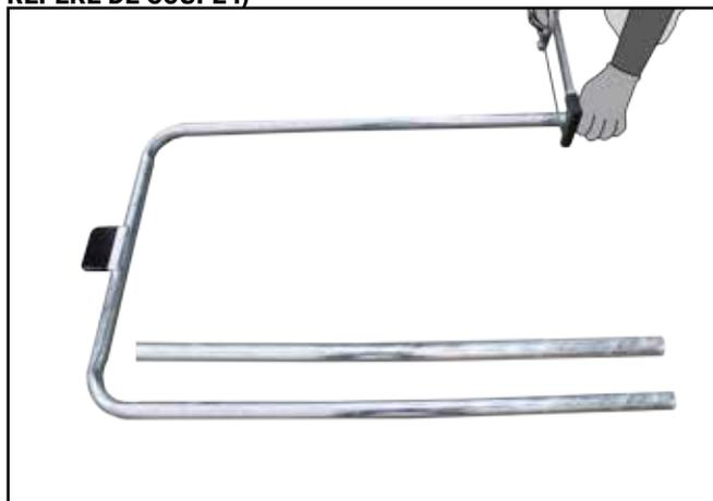
**I.** À l'aide d'une scie à métaux ou d'un outil similaire, coupez soigneusement les 3 tubes supérieur et inférieur. Pour les ensembles galvanisés, pulvérisez de la galvanisation à froid (type Galvafröid ou similaire) pour éviter la corrosion. Repositionnez soigneusement les tubes supérieur et inférieur du portillon dans les raccords.
