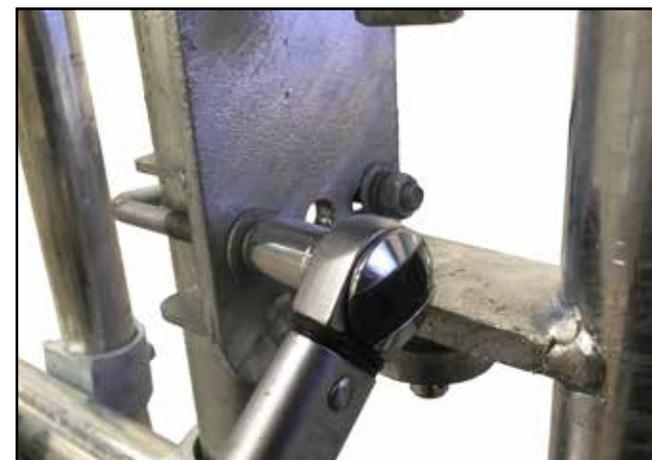
**E.** Serrez les écrous / étriers filetés au couple de 39 Nm, à l'aide d'une douille de 13 ou 17 mm et d'une clé dynamométrique. **Répétez les étapes A à D pour le portillon de droite.**
