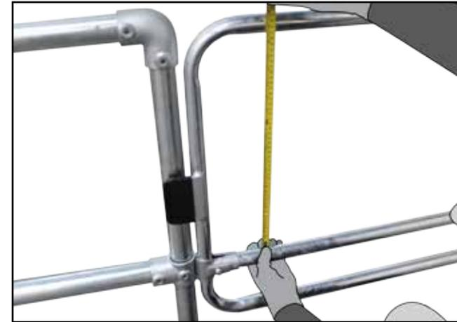
**Q.** Mesurer l'espace entre la lisse haute et la lisse intermédiaire ; celui-ci ne doit pas dépasser 470mm. Ajuster si besoin.
