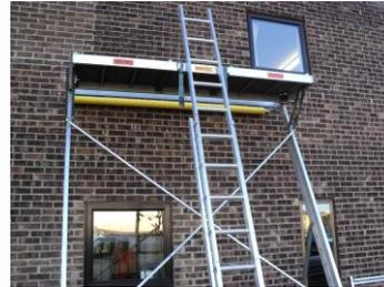
L'échelle est placée contre la plateforme, est étendue d'un mètre au-dessus de la plateforme et positionnée légèrement sur la droite des ergots afin de garantir un passage suffisant sur le côté gauche.
