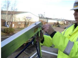
Attachez les tubes de support aux deux extrémités aux poutres de levage en retirant les broches de maintien dans les deux petits trous à chaque extrémité des tubes de support. Ceux-ci sont alors bloqués dans les trous plus importants sur le côté inférieur de la poutre. Les broches sont ensuite remplacées, ce qui les maintient en position.
