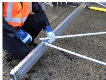
Faites osciller chaque renfort par-dessus la jambe opposée et fixez-le sur l'ergot de fixation au moyen des goupilles beta fournies.
