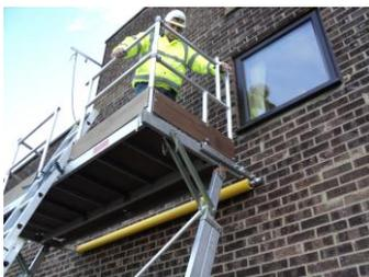
Grimpez sur la plateforme et positionnez les montants arrière dans les réservations de garde-corps arrière sur la plateforme pour le garde-corps gauche et droit.
