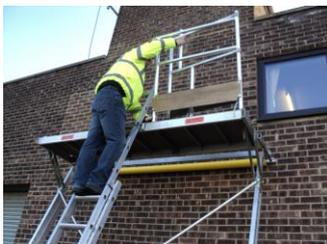
Passez un bras dans l'espace du barreau supérieur de l'échelle, cela vous fournit une poignée pendant que vous mettez le garde-corps en position. **(NOTE : C'est pourquoi l'échelle doit dépasser la plateforme d'1 mètre afin de constituer une poignée)**
