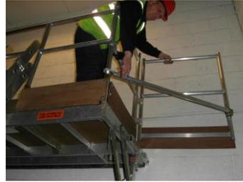
Lorsque vous fixez les portillons à battants (optionnel), suivez la procédure indiquée dans les ÉTAPES 17 et 18. Ouvrez la porte battante depuis l'arrière du garde-corps et faites osciller la porte en position au moyen de renfort en diagonale.
