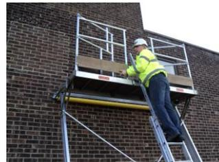
Fixez le garde-corps droit dans les deux réservations de garde-corps avant et ouvrez doucement l'arrière du garde-corps. **NE PAS OUBLIER** : Ayez toujours votre bras dans l'espace du barreau du haut de l'échelle lorsque vous positionnez le garde-corps. Répétez cette opération pour le garde-corps gauche.
