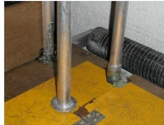
Attachez les cadres de support aux deux extrémités des réservations de maintien en vous assurant que la bride n'est pas dans la trappe et encastrée avec la plateforme.
