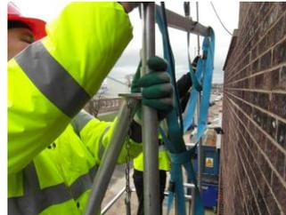
Levez le montage entier en maintenant les tubes de support puis en positionnant ces tubes par dessus le trou dans les cadres de support d'extrémité. **NOTE** : *Érigez la poutre et l'assemblage de monte-charge à poulie est assemblé et positionné depuis la plateforme par deux utilisateurs.*
