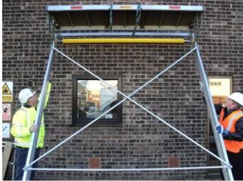
Levez la plateforme solaire jusqu'à la hauteur de votre taille en pliant vos jambes et gardant le dos droit, tout d'abord à la hauteur de votre taille, puis à l'aide de vos bras, pour le monter contre le mur et le faire rouler jusqu'à sa position.
