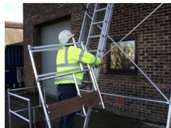
Positionnez le garde-corps au dessus de vos épaules, maintenez trois points de contact pendant que vous grimpez à l'échelle. **NE PAS OUBLIER** : Lorsque vous fixez le garde-corps sur le côté droit de la plateforme, portez-le sur l'épaule droite et répétez l'opération pour le côté gauche.
