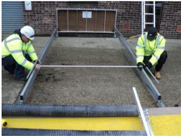
Disposez les composants prêts à être montés avec la plateforme contre le mur avec les roues sur le sol. Identifiez la jambe correspondante pour chaque côté de la plateforme (vert - gauche / rouge - droit)
